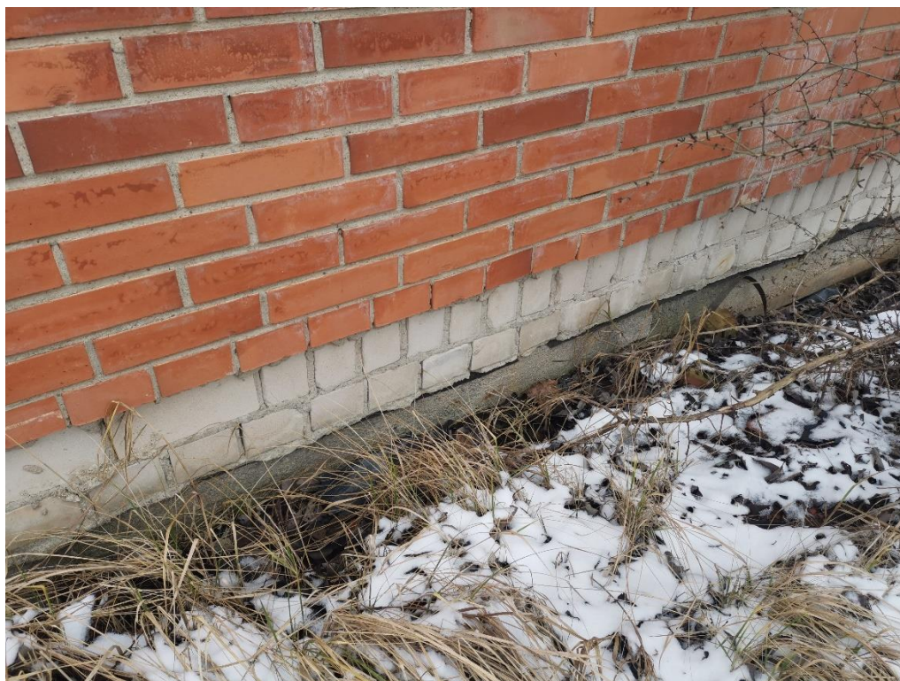
9 pav. Aplink pastatus neįregtos nuogrindos
