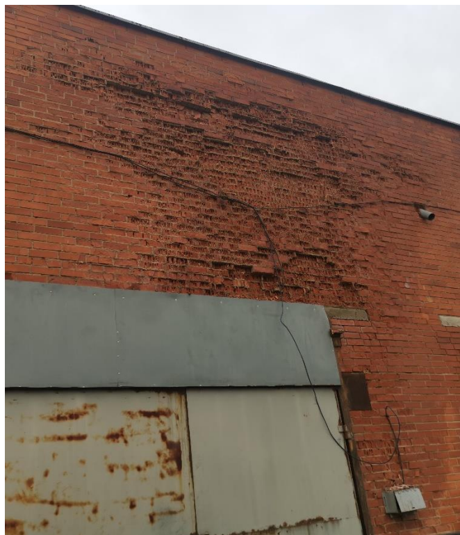
5 pav. Klimatinių poveikių paveiktos sienos
