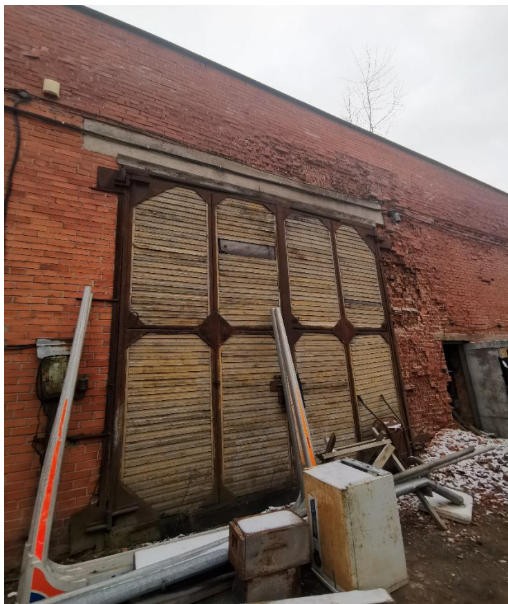
3 pav. Klimatinių poveikių paveiktos sienos
