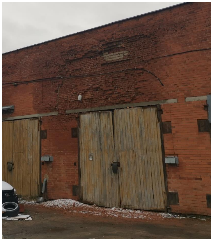
4 pav. Klimatinių poveikių paveiktos sienos
