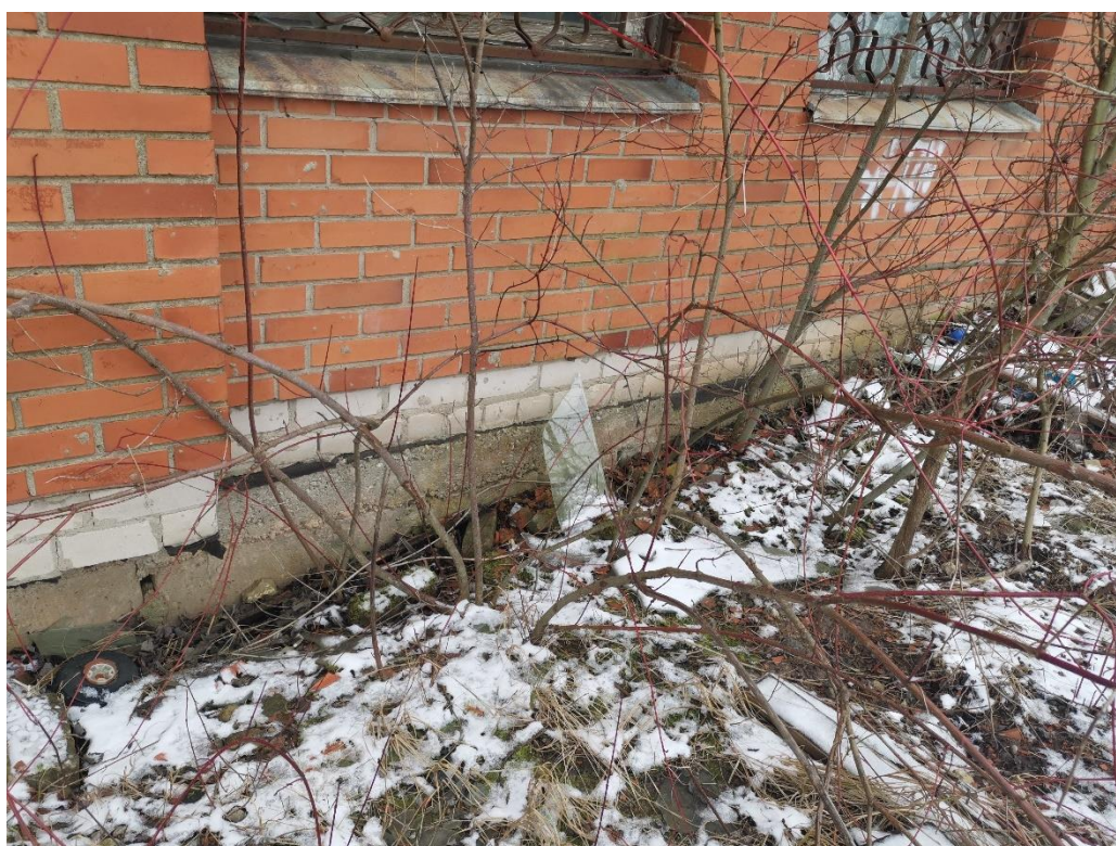
10 pav. Aplink pastatus neįregtos nuogrindos
