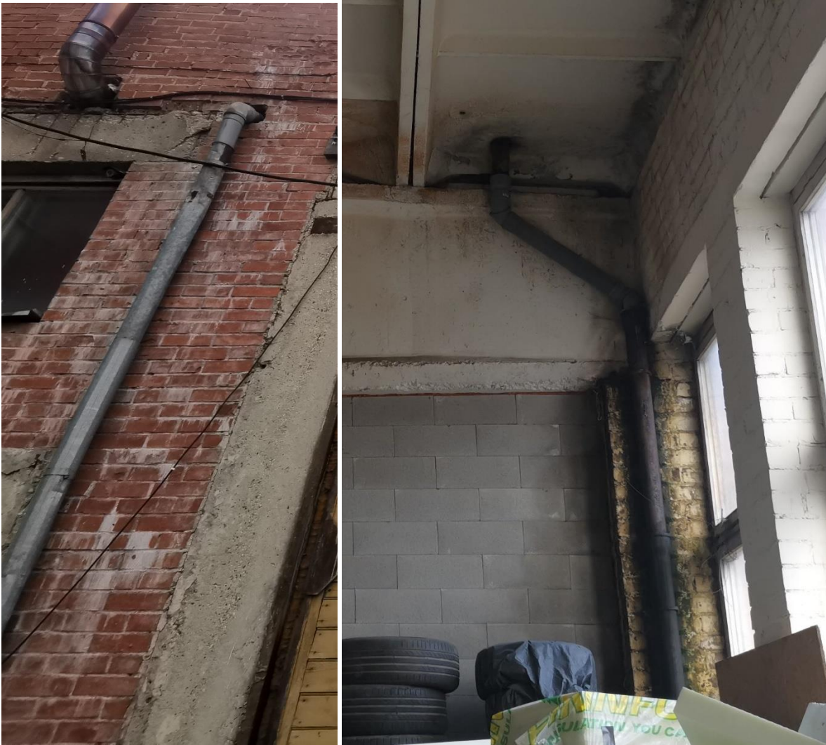
1, 2 pav. Suisidēvējusi lietaus nuvedimo sistema
