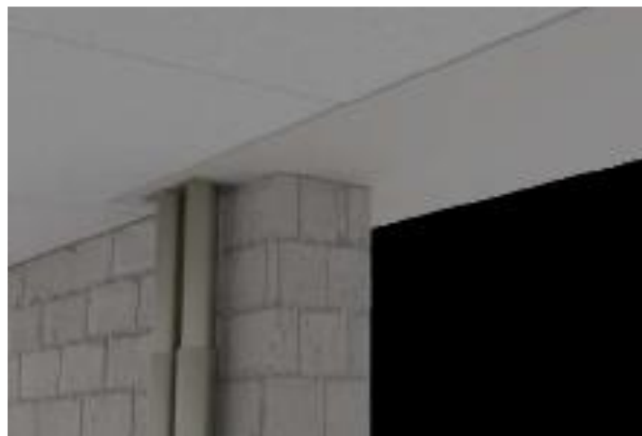
10.6 pav. Išramstymas sijos atrėmimo ant sienos atveju
